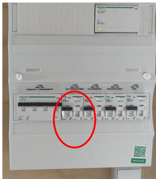
Sikringerne i gruppetavlen er alle af typen automatsikring. Automatsikringer adskiller sig fra de normale smeltesikringer ved, at man ikke skal udskifte sikringen i tilfælde af en kortslutning i installationen eller et af de apparater, du har tilsluttet. Skyldes kortslutningen et af de apparater du har tilsluttet i en
